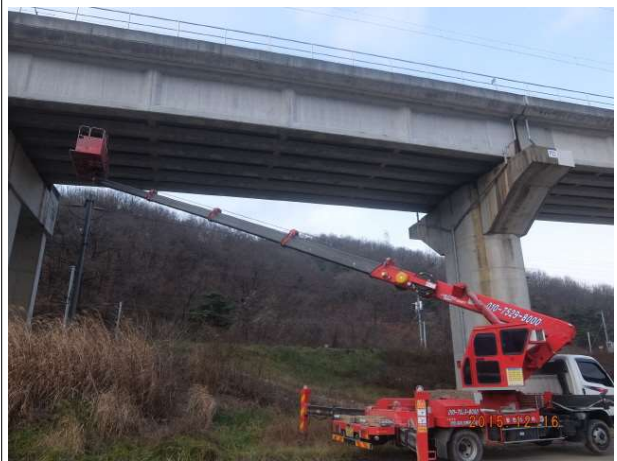
고소점검차를 이용한 외관조사(예)
