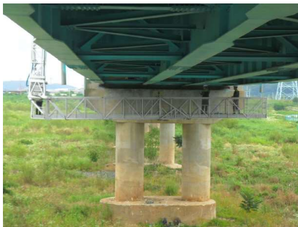
교량굴절차를 이용한 외관조사(예)
